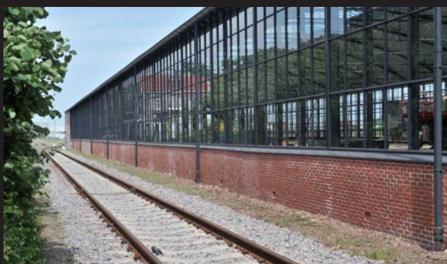
▲ De zijgevels van de loods bestonden uit geprofileerde staalplaten, maar zijn nu vervangen door blank gelaagd glas.
